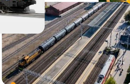
Remonto depo Vaidotuose statyba
